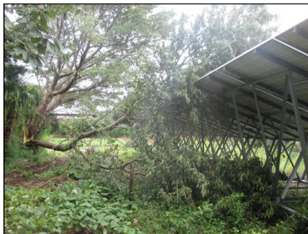
[倒木による設備損壊]
